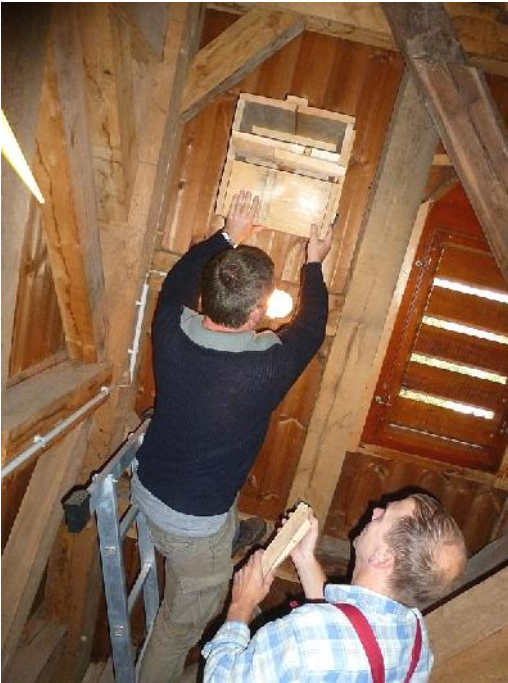
Im Innern des Kirchturms wurden die neuen Dohlennistkästen installiert.
