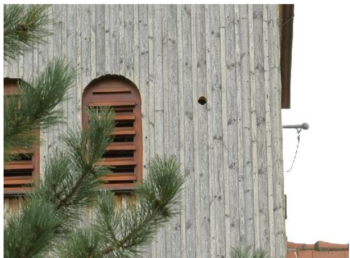
Von außen sind die Einfluglöcher für die Dohlen im Kirchturm zu erkennen.
