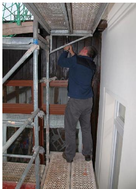
Herstellung und Anbau der neuen Mauerseglernistkästen. Fotos: NABU Leipzig
